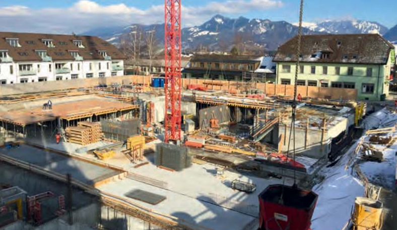
Avancement des travaux aux 2 e et 1 er sous-sols
