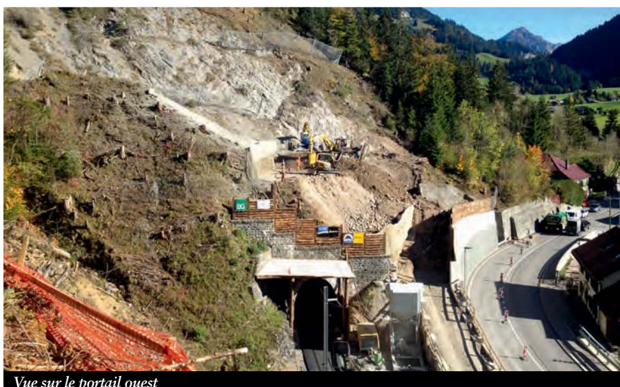
Vue sur le portail ouest
