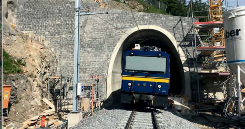
Nouveau portail ouest du tunnel de la Chaudanne
