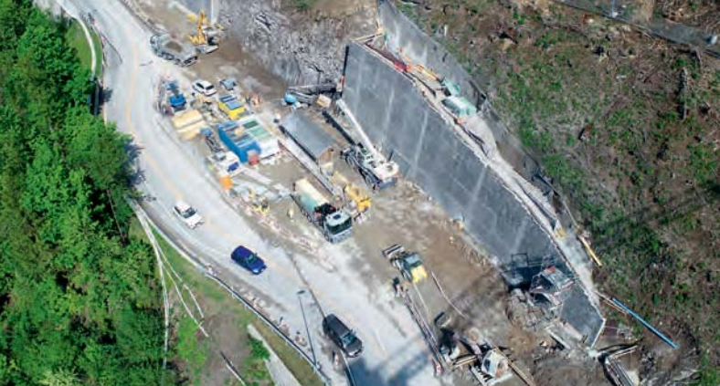
Circulation routière déviée et sortie de chantier à l'arrêt de la Chaudanne
